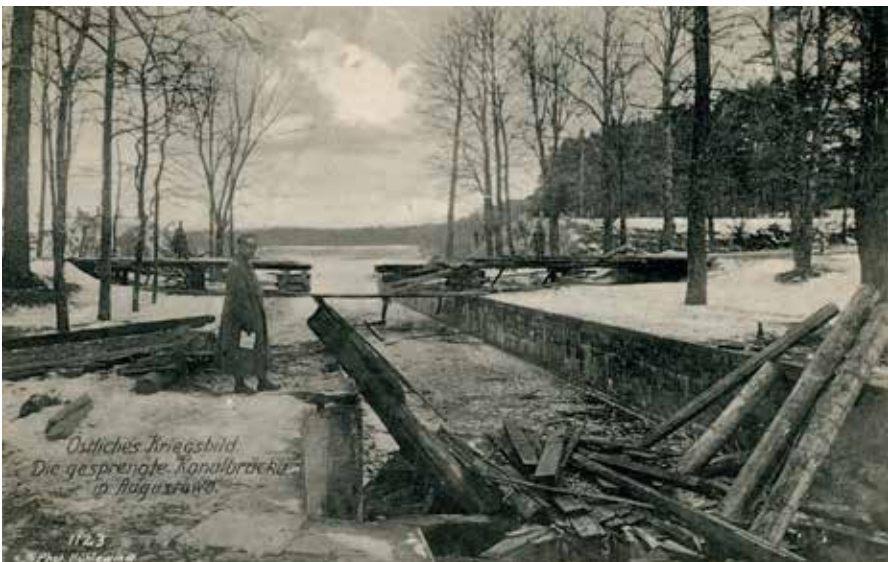
Żołnierze niemieccy przy zniszczonej śluzie w Przewięży, wiosna 1915 roku.
